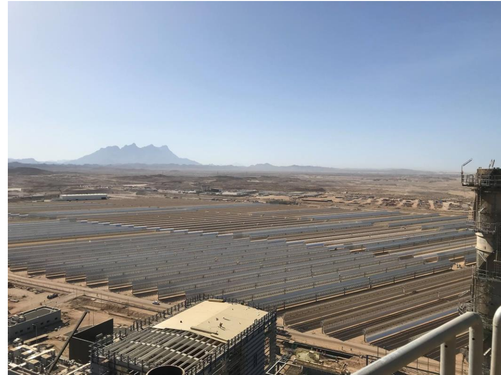
50 MW DUBA Green ISCC, DUBA, KSA, 2017
